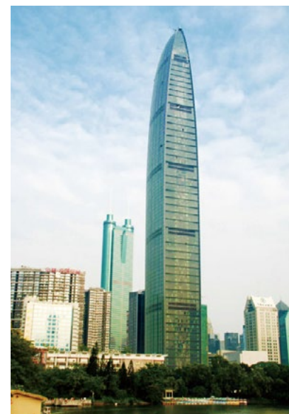
绿色建筑京基100大厦
